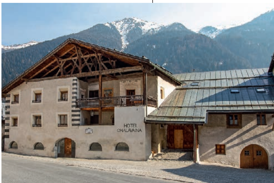
Diese beiden historischen Häuser bilden das Hotel Chalavaina in Müstair.
